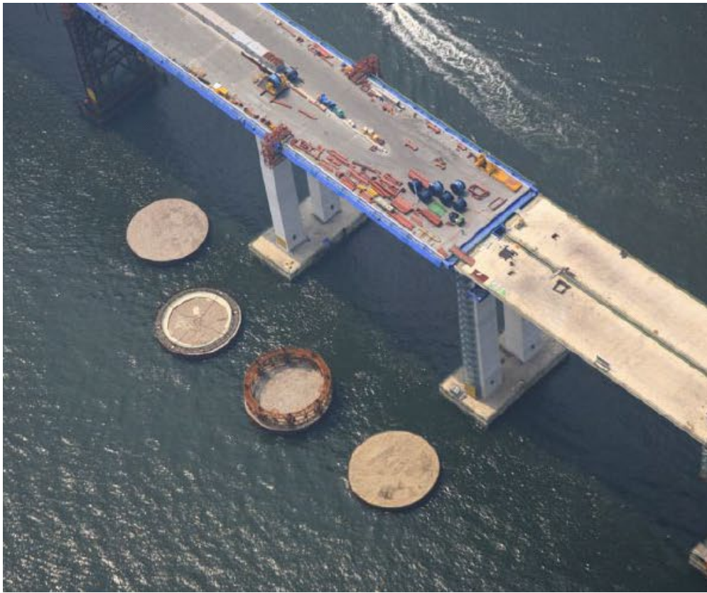
Рисунок. 2.1.9 – Оболочки с наполнителем в качестве защиты опор моста (Incheon Bridge, Южная Корея) [222]
