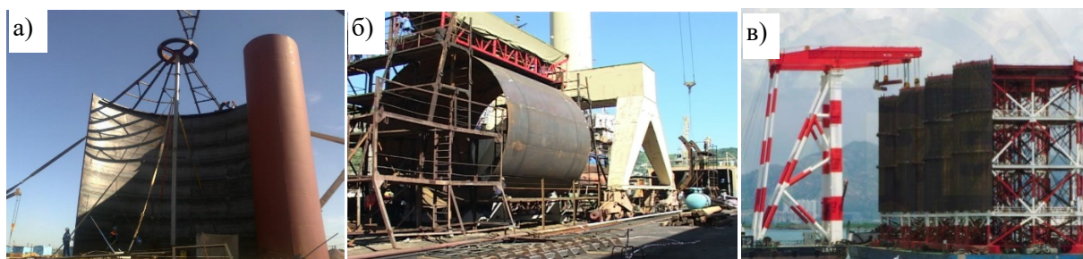
Рисунок 2.2.2 – Процесс производства металлической оболочки
