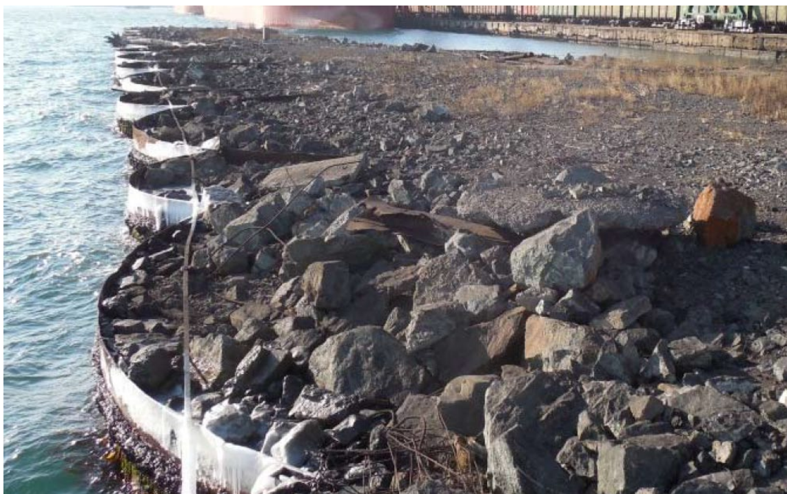
Рисунок 1.4.2 – Отклонение заполненных оболочек в порту г. Находка [181]
